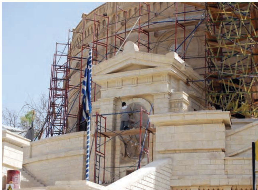
Κατά τη διάρκεια των εργασιών συντήρησης Conservation works in progress
