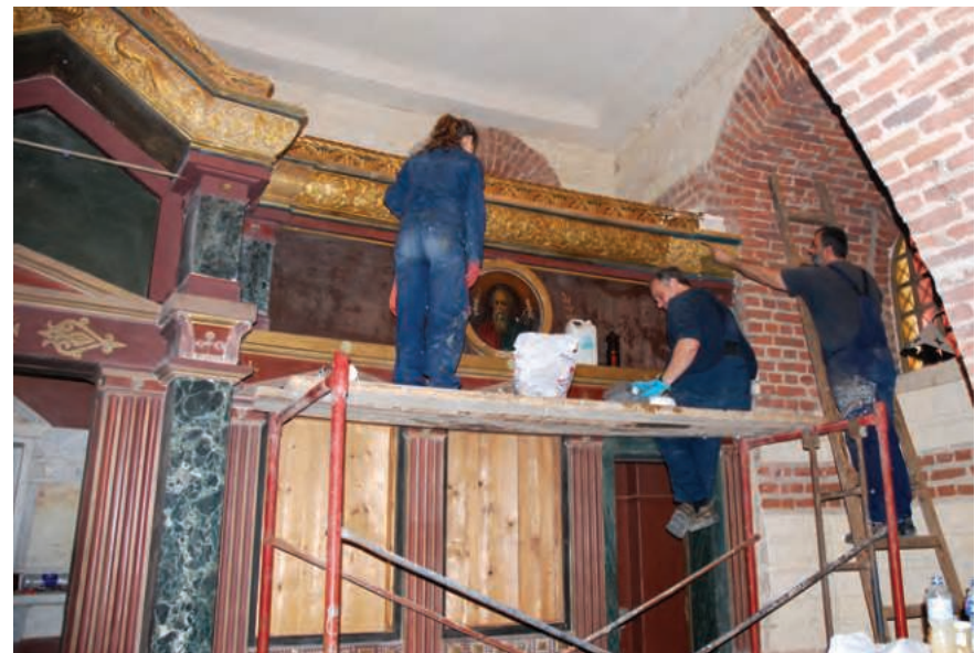
Κατά τη διάρκεια των εργασιών συντήρησης Conservation works in progress
