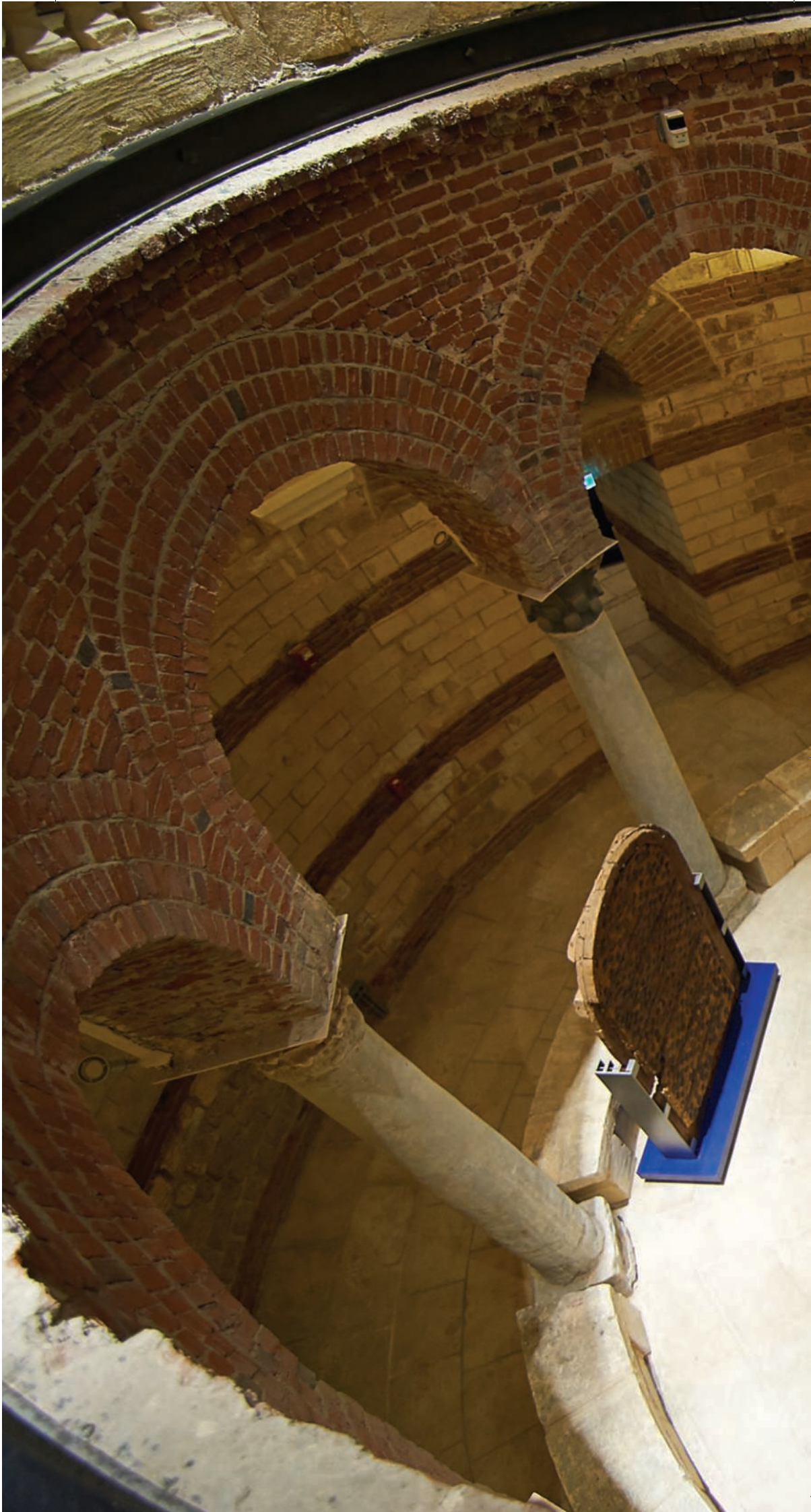
Αποψη του εσωτερικού του πύργου (β' επίπεδο) View of the interior of the tower (2nd level)
