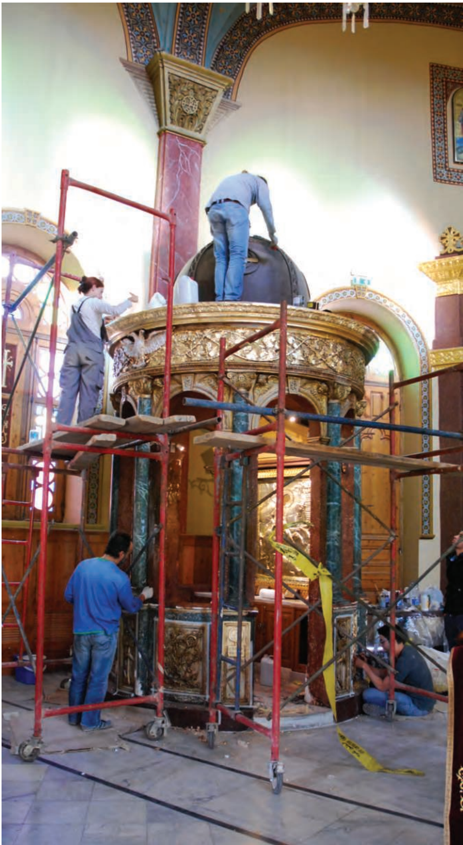
Κατά τη διάρκεια των εργασιών συντήρησης Conservation works in progress
