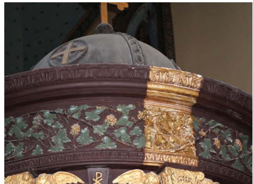
Λεπτομέρεια κατά τη διάρκεια των εργασιών συντήρησης Detail from conservation works in progress
