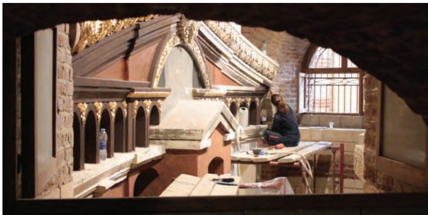
Κατά τη διάρκεια των εργασιών συντήρησης Conservation works in progress
